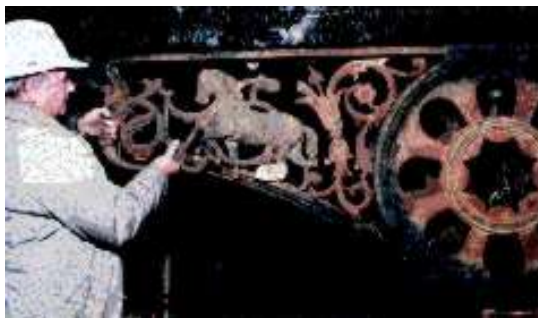
UMA CONSOLA FUNDIDA ANTES DE SER REPARADA
