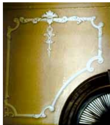
Com base em evidências físicas e documentais, foi recriada a composição ornamental em falta. Fotografia : Jonathan Thornton.
