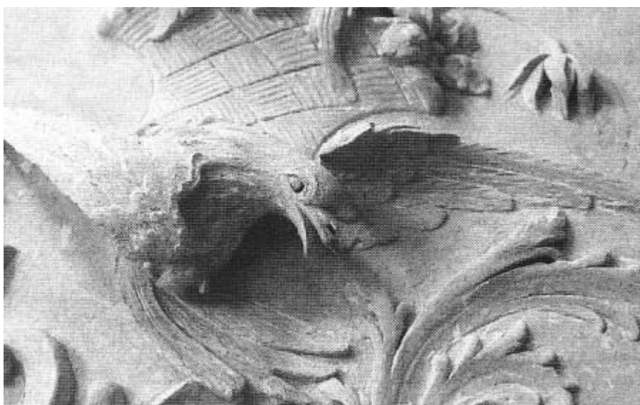
20 Dominick Street – Típico pássaro Rococó conforme popularizado por Robert West, depois de limpo e da reparação do bico.
