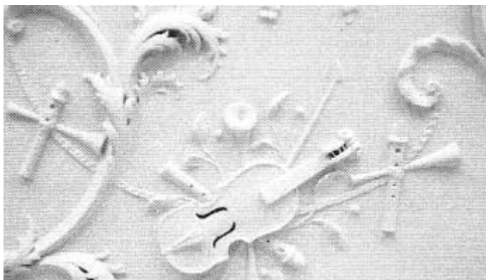
20 Dominick Street - Tecto após reparação com Classidur
