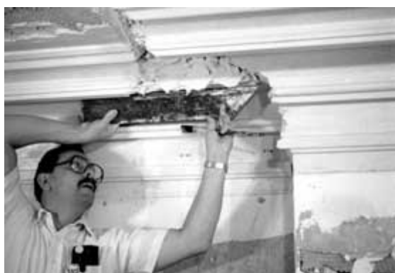
A operação de correr uma moldura lisa exigia uma grande perícia na utilização de um molde de correr. Fotografia : Old-House Journal.
