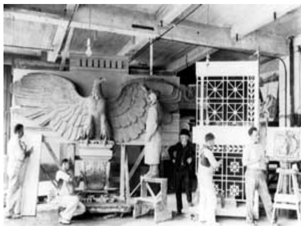
Estúdios de estuque ornamental empregando uma larga variedade de pessoal, incluindo escultores, que modelam em barro; modeladores que fazem as unidades de produção; e acabadores que aperfeiçoam os modelados.
