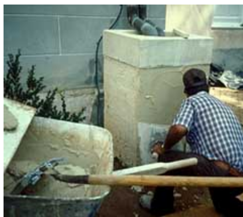
Aplicação de "stucco" novo na superfície degradada desta caixa de recepção de águas pluviais. Fotografia dos arquivos do NPS.
