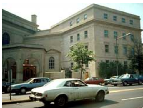
A nova adição à direita é “stucco” arranhado para imitar a pedra calcária do edifício histórico à esquerda. Fotografia dos arquivos de NPS.
