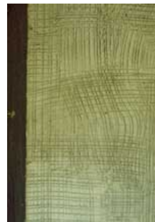
A camada de acabamento final é aplicada sobre esta camada “arranhada”. Fotografia dos arquivos do NPS.
