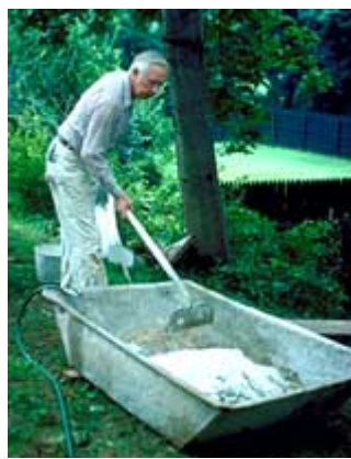
Os materiais devem ser cuidadosamente misturados em seco antes de se adicionar a água para a preparação do “stucco”. Fotografia dos arquivos do NPS.
