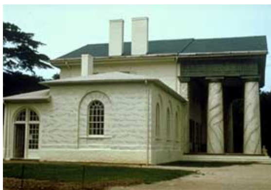
O acabamento a “stucco” da Arlington House, Arlington, Virginia, foi marmoreado em 1850, aproximadamente 30 anos após a sua construção.
