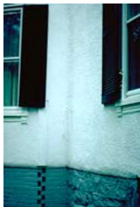
O “stucco” desta casa tem um acabamento áspero. Fotografia dos arquivos do NPS.
