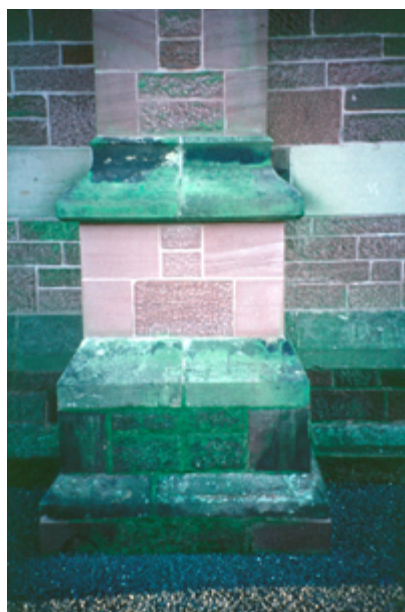
Crescimento de algas sobre um arenito dois anos após limpeza
