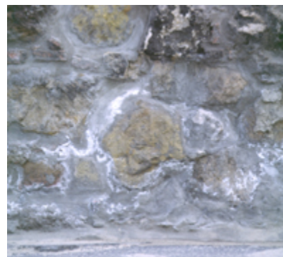
Cristalização de sais provenientes da água do solo
