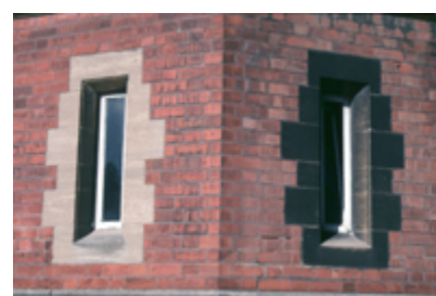
Conspuração diferencial de um arenito controlada pelo aspecto
