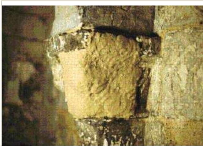
Ensaio de limpeza numa fachada em estuque de cimento do Séc. XIX pelo emprego de um emplastro de carbonato de amónio em argila e fibra de papel.
