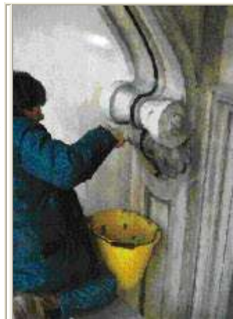
Ensaio de limpeza de um pormenor sobre uma fachada em estuque de cimento do Séc. XIX, pela utilização de carbonato de amónio num emplastro de argila e fibra de papel.
