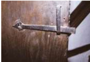
Figura 2. Este trinco típico do século XVII está directamente fixado a uma aldraba do outro lado da porta. Os dois topos cortados do eixo que liga a aldraba ao trinco podem ser vistos facilmente a sobressaírem através do furo no centro de rotação à esquerda, onde ele foi dobrado para se cravar no trinco. Reparar na cruz de Santo André gravada e na linha decorativa.
