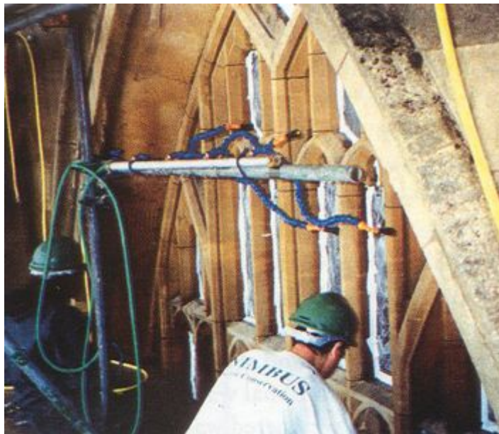
Cabeças flexíveis dirigindo uma aspersão fina cuidadosamente controlada sobre mulhões em pedra (fotografia de Nimbus Conservation Limited)
