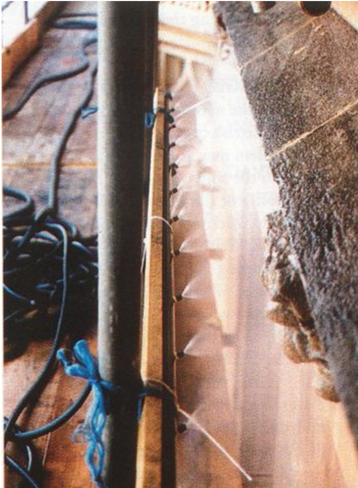
Cabeças fixas criando um efeito de névoa em áreas planas de alvenaria (fotografia de Paye Stonework & Restoration Ltd)
