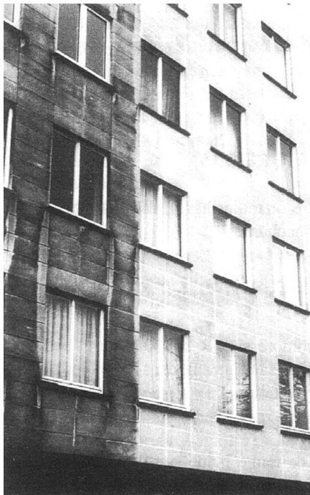
Fig.1 Limpeza de uma fachada. A técnica usada permitiu uma eliminação das camadas de sujidade salvaguardando sempre as gradações de cor próprias do material bem
