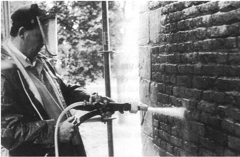
Fig. 10 Equipamento de projecção com duas mangueiras e um bico de projecção.
