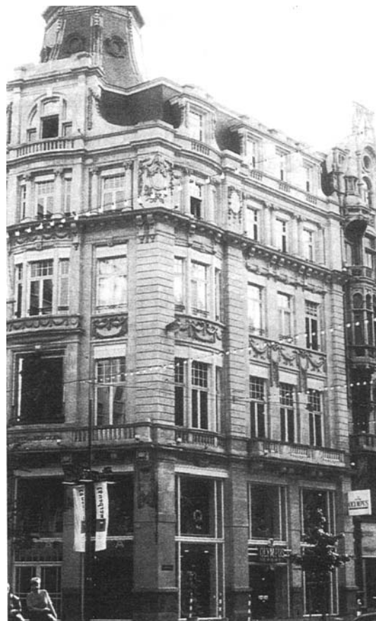
Fig. 6 Fachada limpa com vapor saturado.
