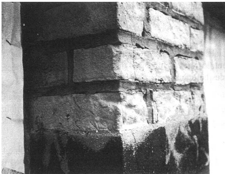
Fig. 12 Danos provocados pelo hidrojecto a muito alta pressão.
