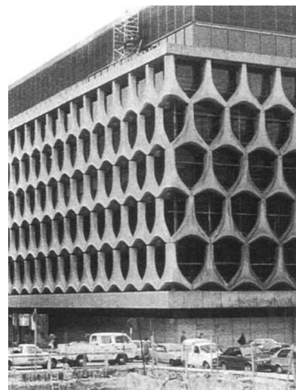
Fig. 8 Limpeza de um edifício em betão arquitectónico por meio de um produto à base de bifluoreto de amónio (a parte esquerda está limpa).
