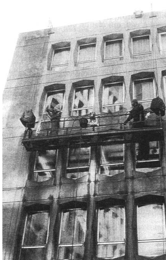
Fig. 7 Limpeza com água a alta pressão.
