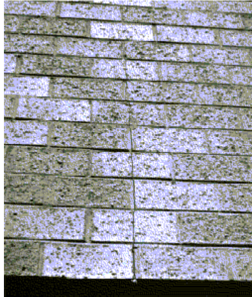
Fig. 9 – Fractura consequente de deflexão
