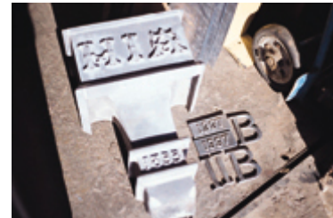
Uma peça de chumbo reparada para a Catedral de Ely
