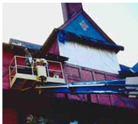
Nesta moldura usou-se um fogão eléctrico para a remoção da tinta. Fotografia : Arquivos do NPS.
