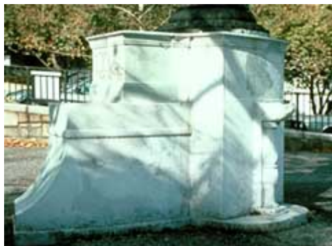
Pintar-se sobre os graffiti existentes numa pedra não é um método de manutenção recomendável. Fotografia : Arquivos do NPS
