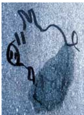
Emplastro usado para a remoção de graffiti com um porco. Fotografia dos Arquivos do NPS.
