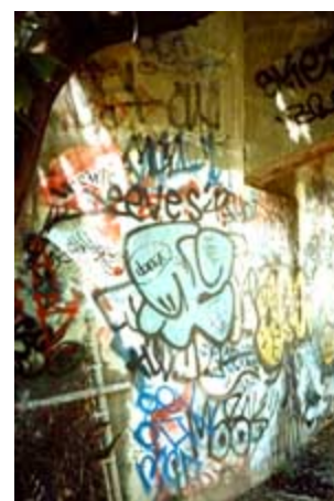
A remoção destes graffiti densamente pintados exige várias aplicações de decapante para tinta. Fotografia : Arquivos do NPS.
