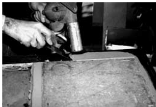
A folha de janela pode ser removida e reparada numa área cómoda. Nesta janela a tinta está a ser removida com um maçarico de ar quente. Fotografia : Arquivos do NPS.
