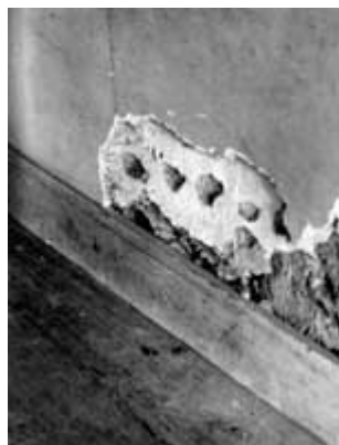
Os construtores desta casa de meados do século XVIII instalaram a tábua de rodapé antes, depois aplicaram um estuque de lama e crina de cavalo. Só foi usada cal na camada de acabamento. Fotografia : Arquivos do NPS.
