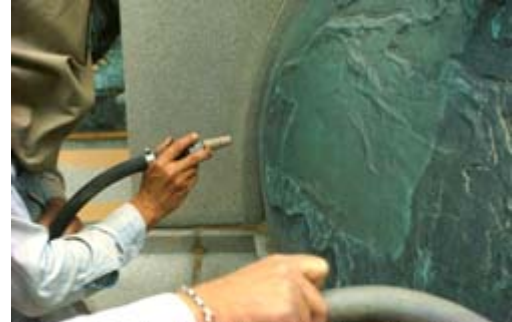
Fig. 7 – Gen. Thaddeus Kosciuszko , de Antoni Popiel, 1910, bronze e granito. Washington, DC. Pormenor da projecção com casca de noz de uma superfície de bronze corroída, 1987. (Montagna)
