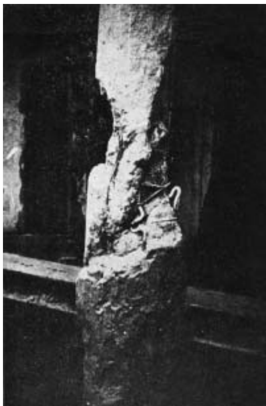
Fig. 32 – Estaca de ensaio (moldada no solo) esmagada durante a carga
