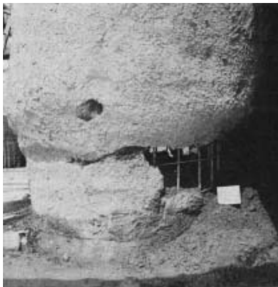
Fig. 38 – Estaca moldada com lamas : discontinuidade
