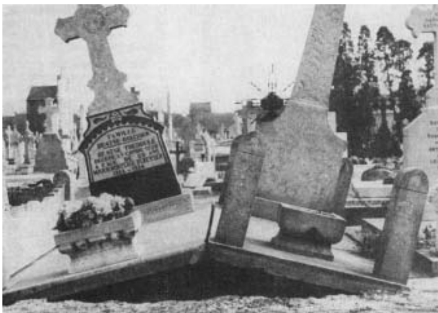
Fig. 29 – Desordens afectando um cemitério na sequência de compressões devidas a movimentos mineiros
