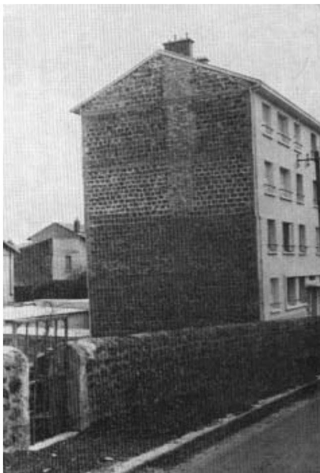
Fig. 5 – Inclinação adquirida por um prédio fundado sobre aterros (fossos das muralhas de uma cidade)
