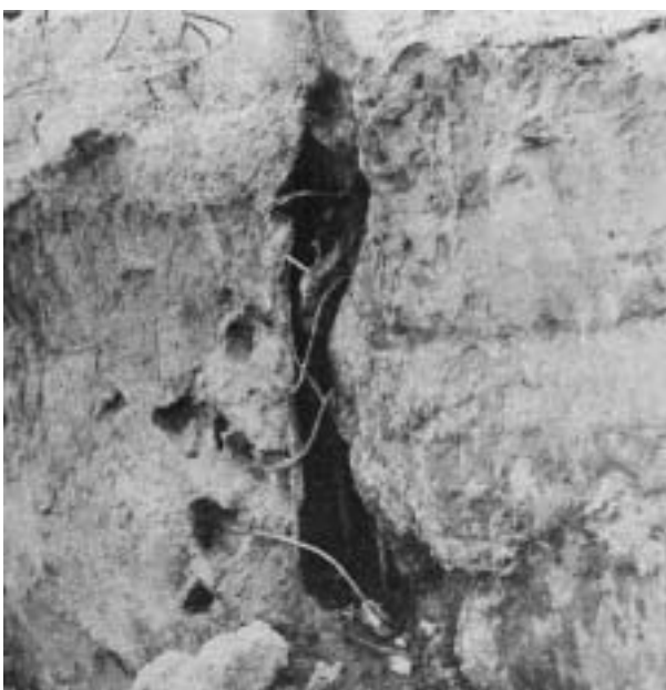
Fig. 41 – Parede moldada executada por uma empresa principiante
