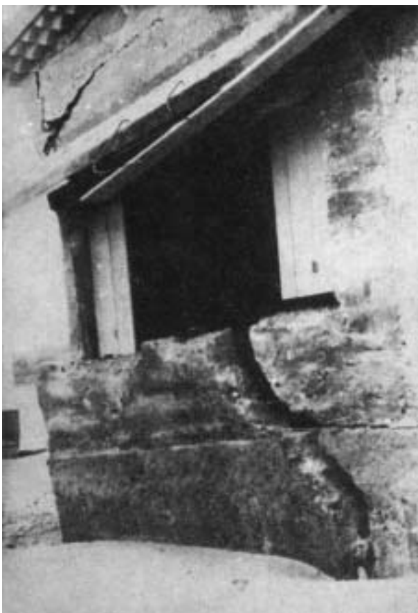
Fig. 24 e 25 – Moradia fundada a uma profundidade insuficiente, junto a uma praia
