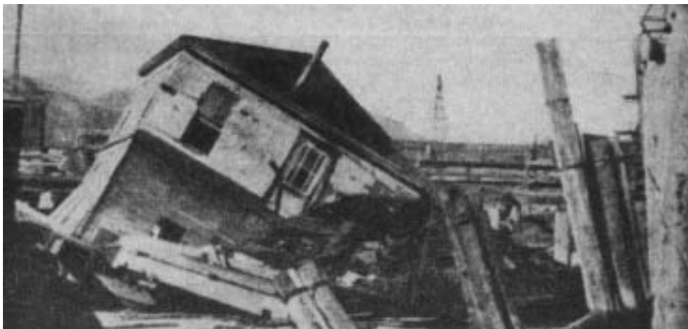
Fig. 46 – Desmoronamento de um edifício fundado sobre estacas em madeira
