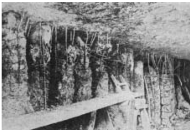
Fig. 40 – Parte superior de uma cortina de estacas adjacentes betonadas com lamas
