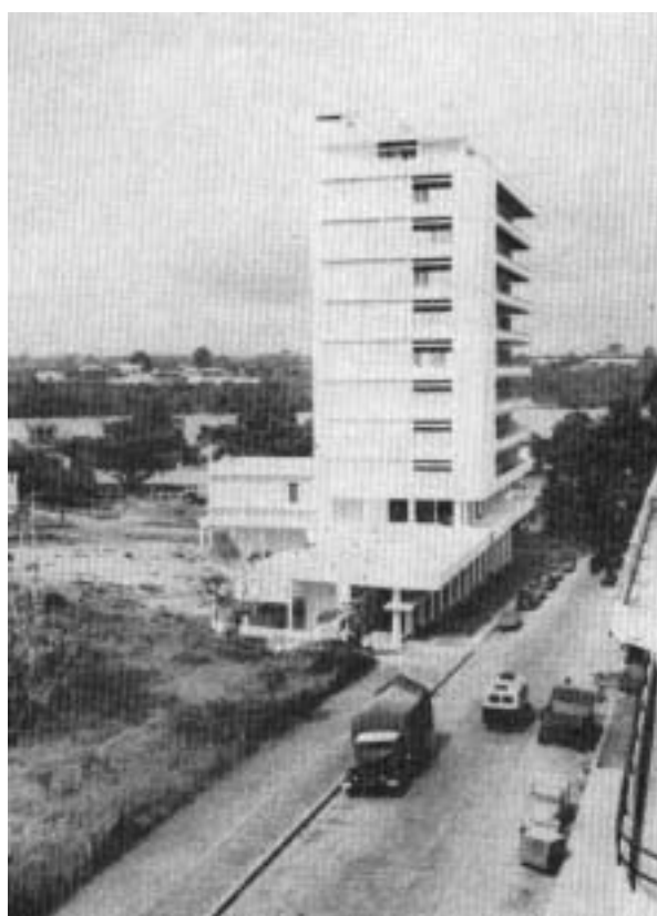
Fig. 1 – A construção baixa estava parcialmente edificada sobre aterro
