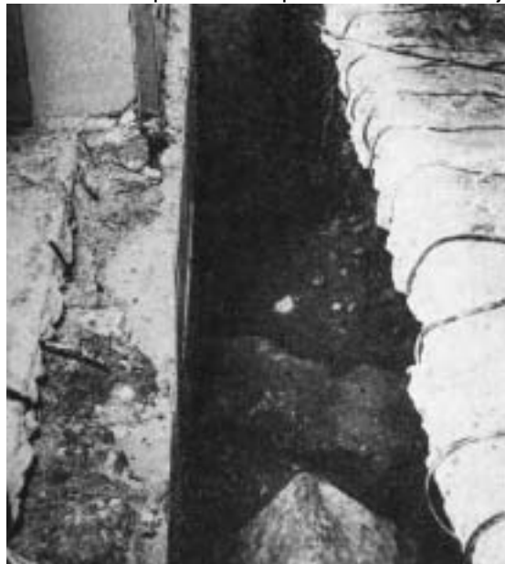
Fig. 18 – Grandes blocos de pedra existentes no aterro
