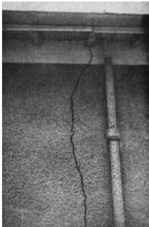
Fig. 2 – Fissura, atingindo 6 cm, nas paredes de um pavilhão fundado sobre aterro
