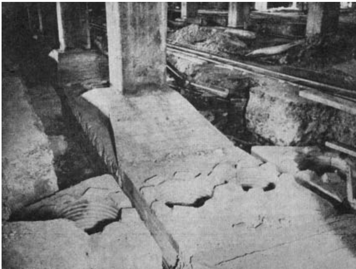
Fig. 21 – Estação Marítima : vista das sapatas mostrando as chaminés para as estacas
