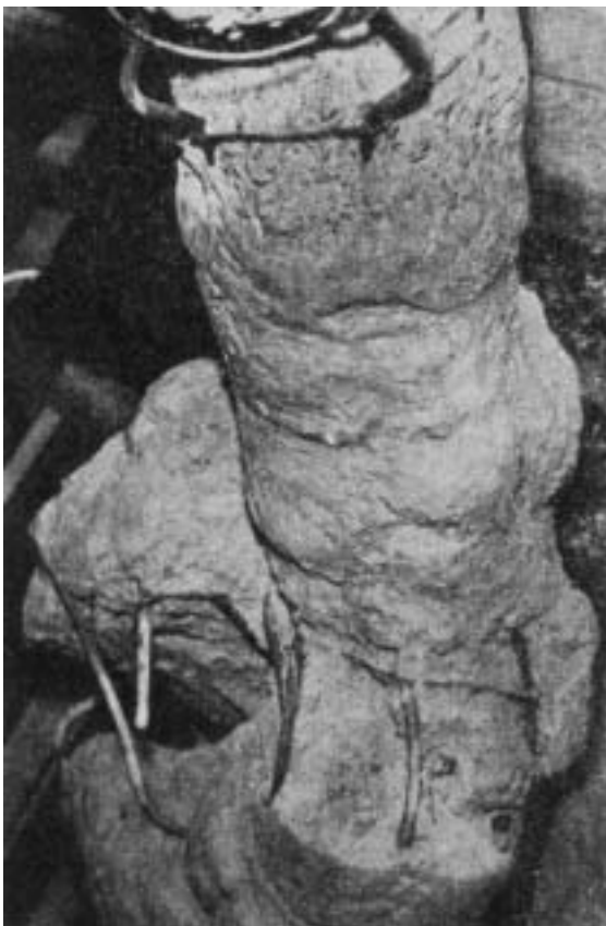
Fig. 31 – Estaca com tubo recuperado executada através de vasas
