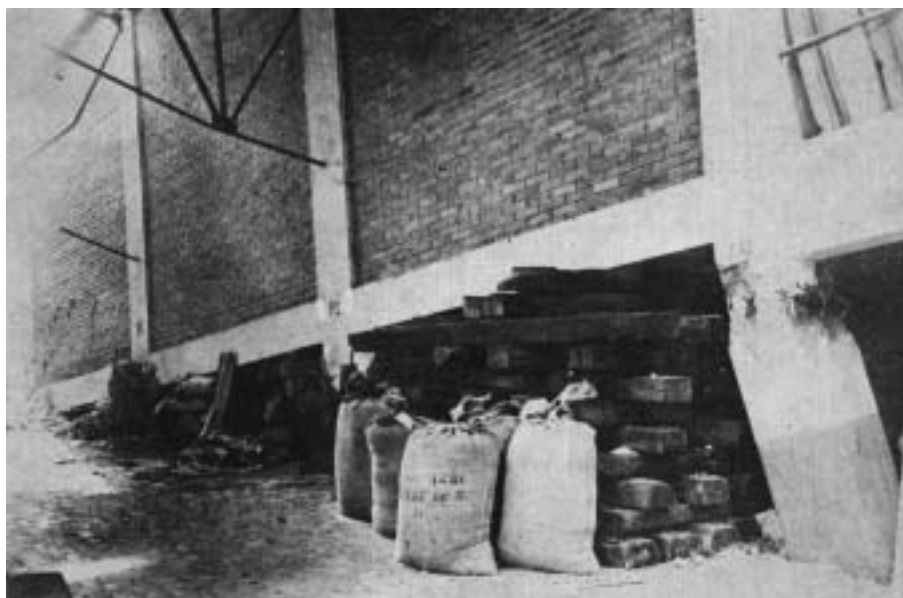
Fig. 50 – Vista do silo assente sobre o solo
