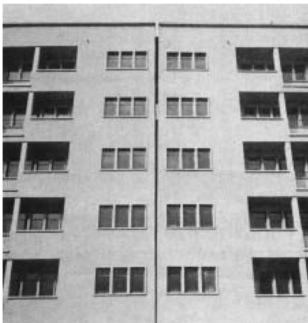
Fig. 34 – Pormenor da junta
