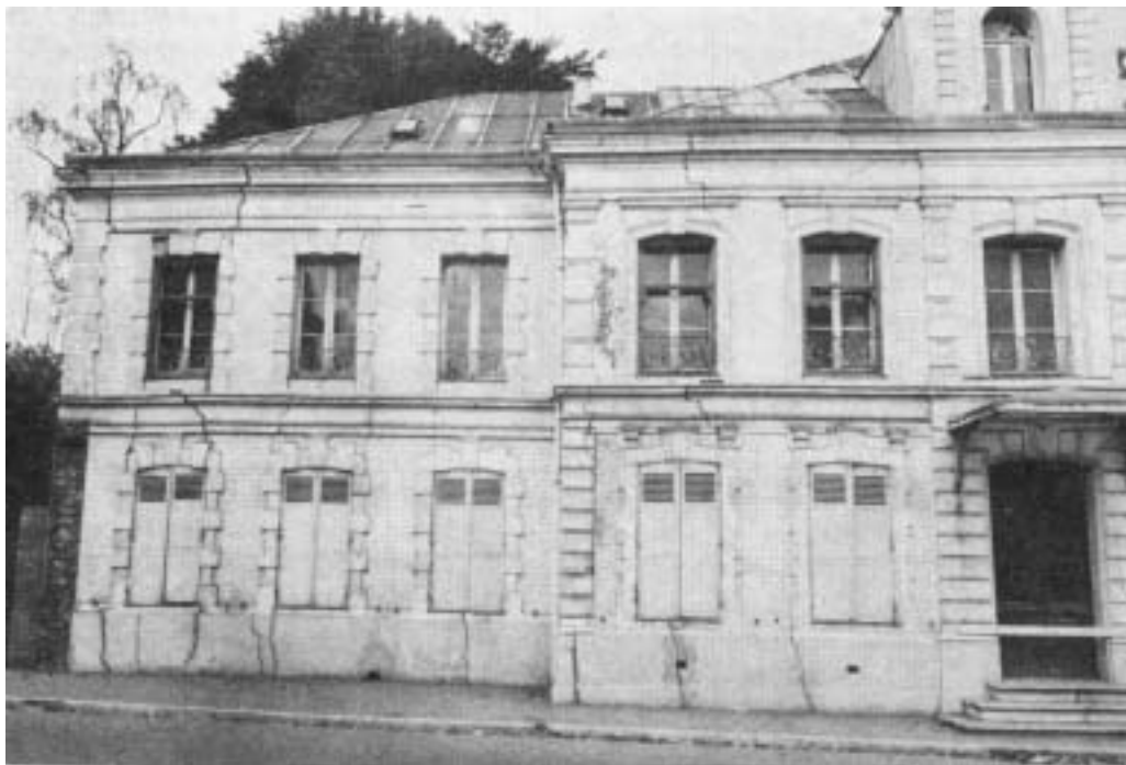
Fig. 30 – Imóvel fundado numa zona de extensão
