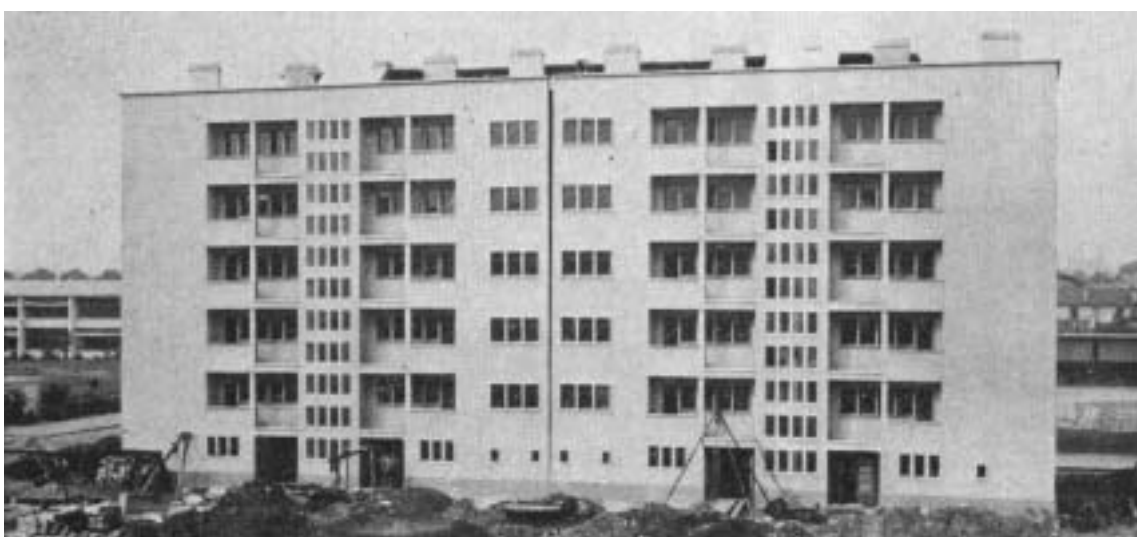
Fig. 33 – Vista de um imóvel. Abertura da junta
