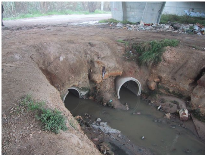
Descarga de esgoto para o Rio Trancão junto à ponte do IC2
