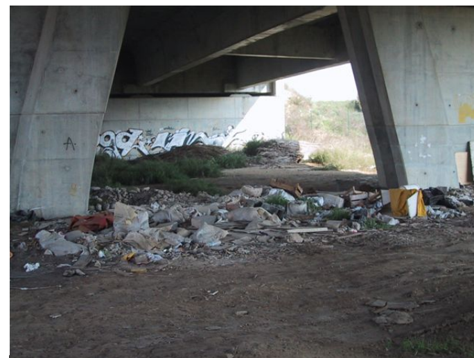
Lixeira espontânea sob a ponte do IC2 sobre o Rio Trancão
