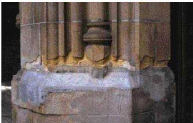
Reparação densa, à base de cimento, num arenito do Colégio de Trinity, em Toronto. Os sais contra o gelo e a humidade subiram por detrás da banda impermeável de cimento para criarem uma nova zona de degradação logo acima desta. (Professor John Ashurst)
